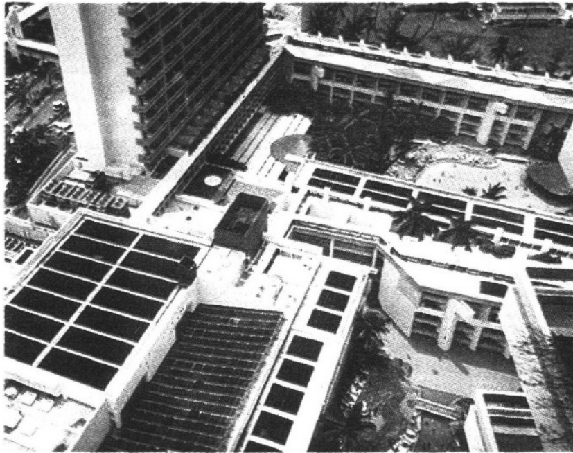
AZOTEA SOLAR. FOTO: CORTESÍA HELIOLCOL
