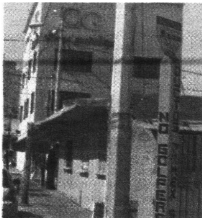
Aunque existen muchos letreros de este tipo en zonas urbanas, en especial este gasoducto y las gaseras cercanas son una bomba de tiempo que urge retirar.
