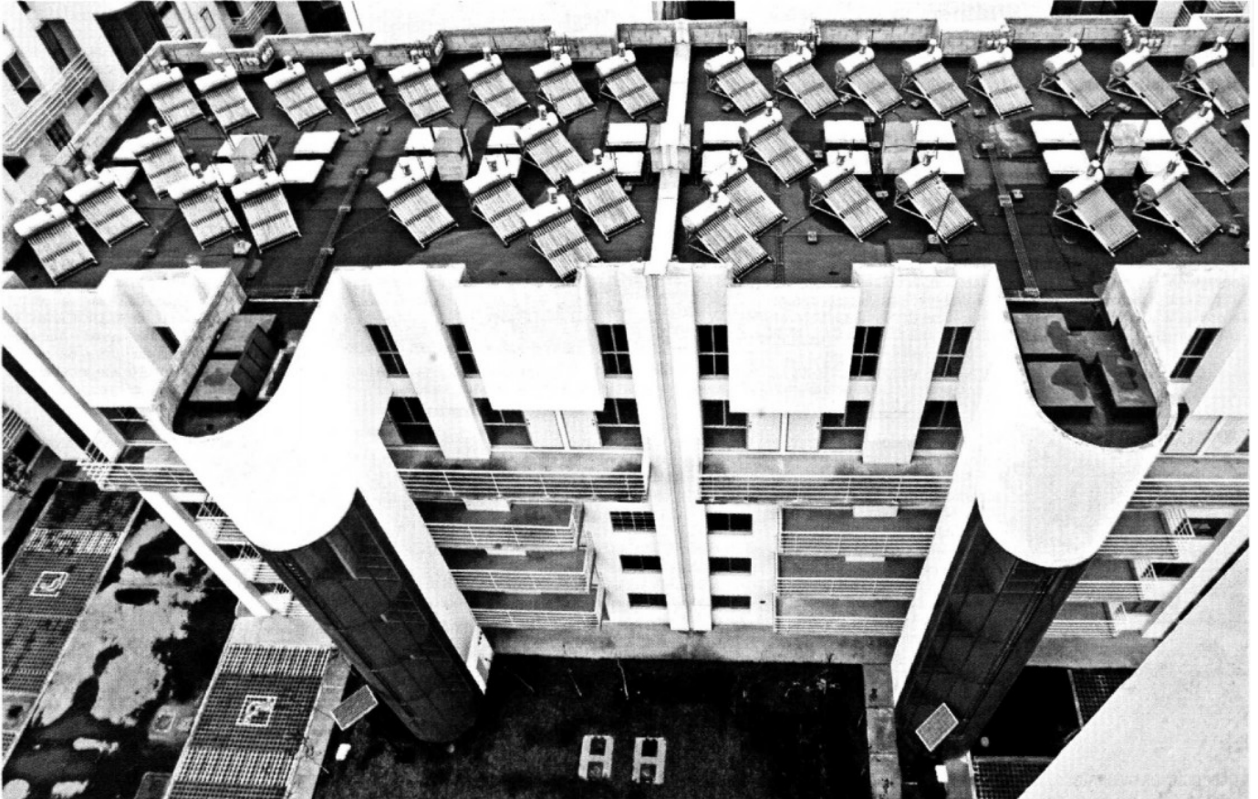
CONCIENCIA ECOLÓGICA. El último conjunto urbano que inauguró el Instituto de Vivienda (Invi) del DF, en marzo pasado, fue en la calle de Aldana 11, Colonia Cosmopolita, en Azcapotzalco, y éste cuenta con avanzados sistemas de calentadores solares, entre otros equipos sustentables.
