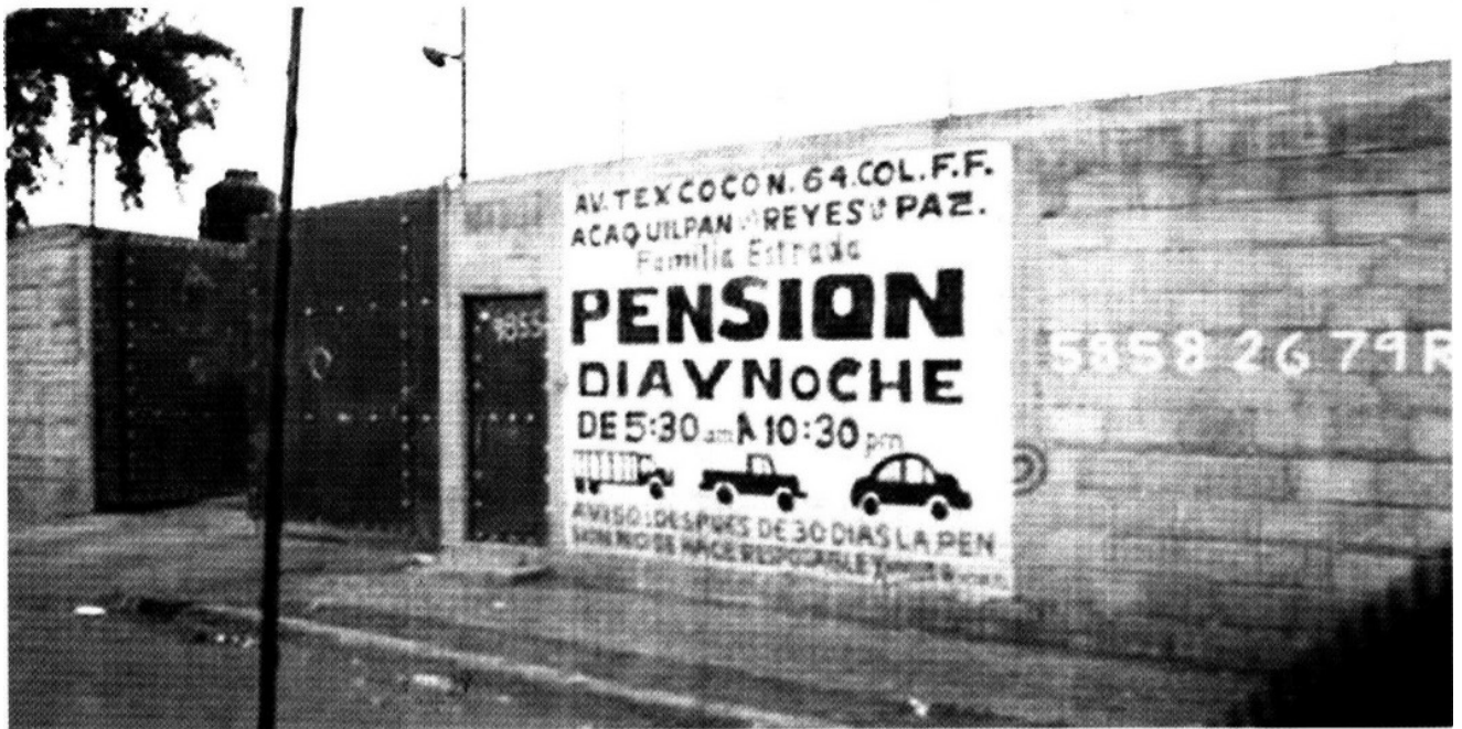
En este predio está el peligro latente de una explosión de gas de grandes dimensiones
