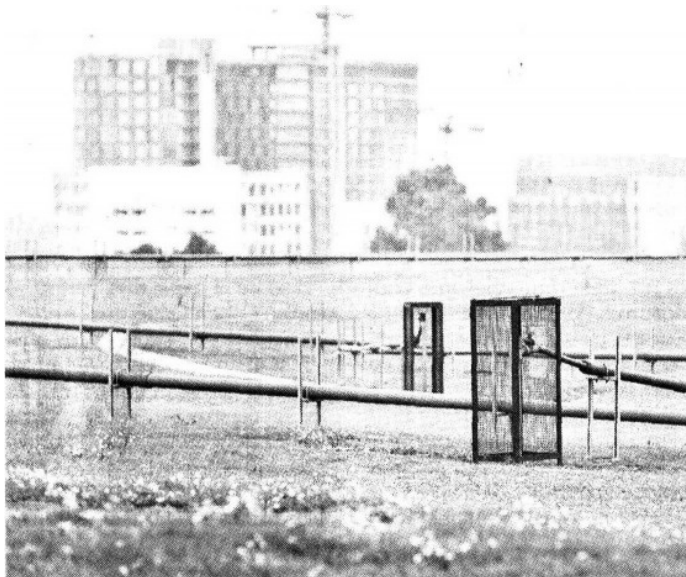
➤ E GDF planea enterrar la red de tubos que ventean el biogás.
