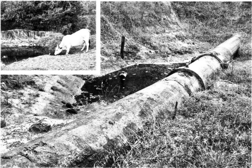
En Cárdenas, Tabasco, fue descubierto un derrame de crudo en una extensión de más de 600 metros cuadrados a consecuencia del mantenimiento inconcluso de ductos.
