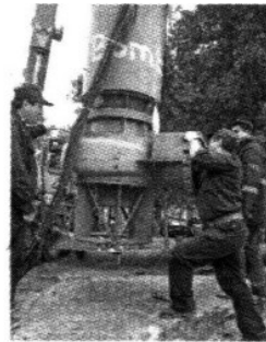
Rehabilitación del drenaje profundo en La Raza
