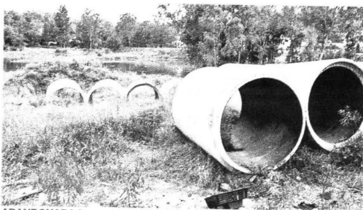
ABANDONADA Sanear la Presa Guadalupe, en Izcalli, Estado de México, les ha llevado tres años y todavía no la terminan.
