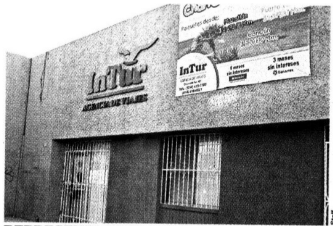
REPRESENTACIONES INTUR S.A. DE C.V. El inmueble luce abandonado, en la calle Coronado 421, en el Centro.
