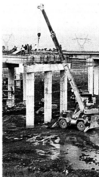
Obras para evitar inundaciones
