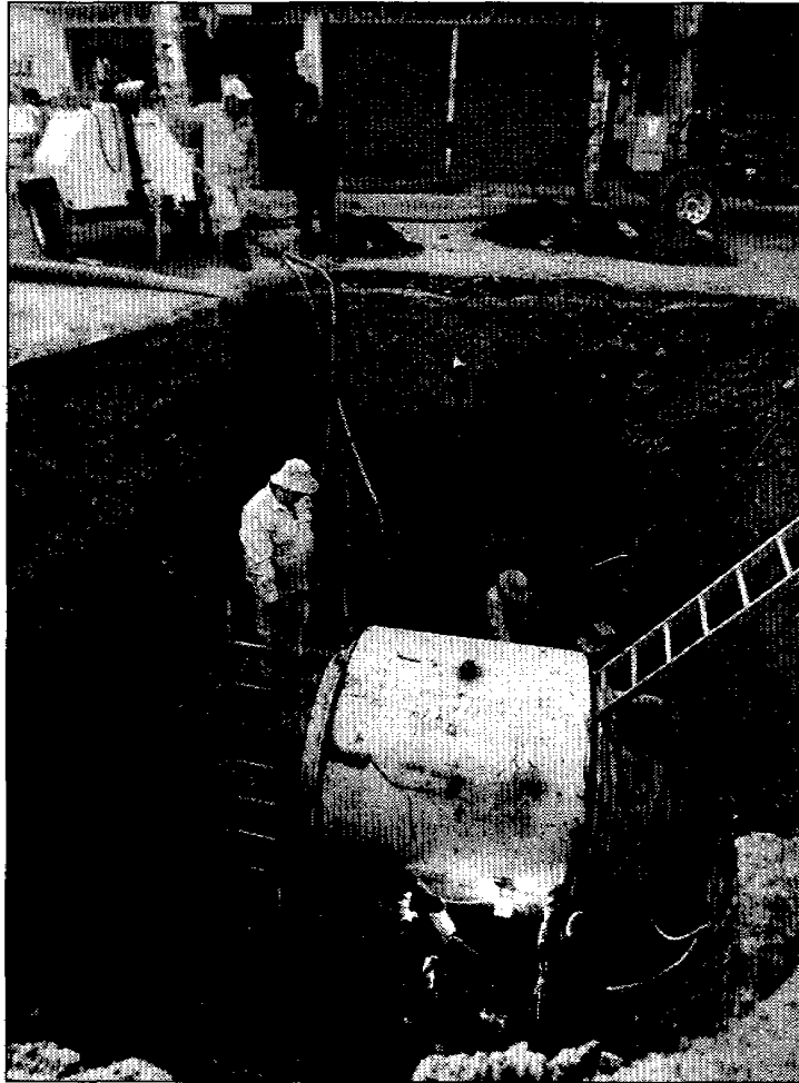
Aspecto de la reparación del acueducto la Caldera, que surte de agua a 27 pozos del DF y estado de México ■ Foto Jesús Villaseca
