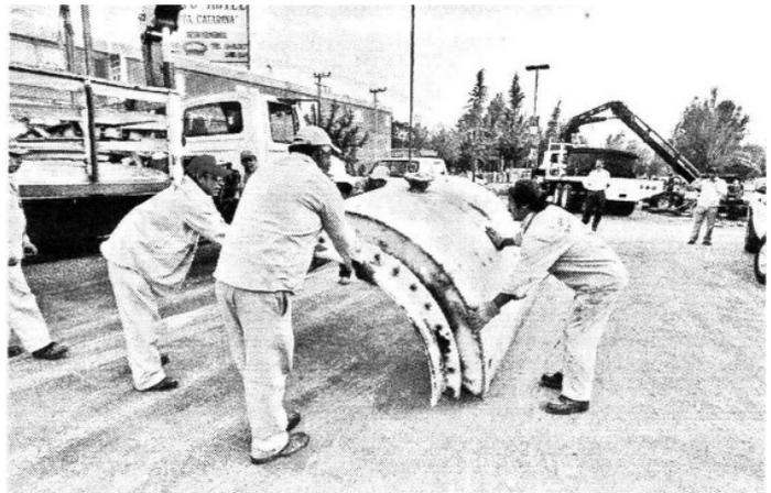
La fisura del tubo será reparada mediante la colocación de un sello de acero; el tubo de 120 centímetros de diámetro conduce mil 200 litros por segundo.
