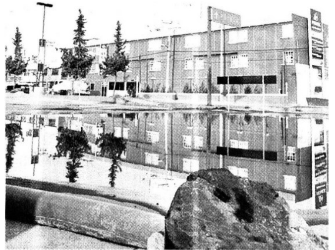
> Miles de litros de agua potable se desperdiciaron por la fisura, provocada por las irregularidades formadas en el terreno.
