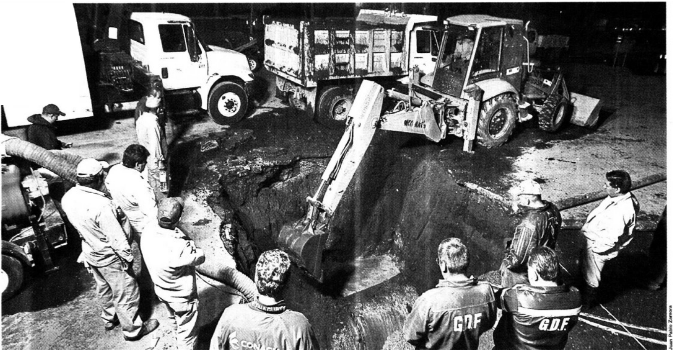
HUESO DURO DE ROER. Los trabajadores tardarán más de 48 horas en reparar la fuga que inició el domingo, deben dejar al descubierto, y seco, el tubo afectado.
