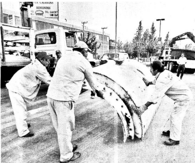
> El tubo fracturado tendrá su "cabestrillo": los trabajadores ya tenían lista la pieza de acero que colocarán al ducto para evitar más fugas.
