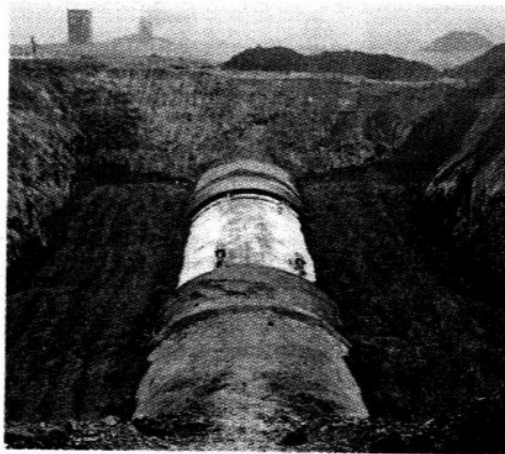
► El cambio en la línea 2 del Cutzamala concluyó ayer en la madrugada.
