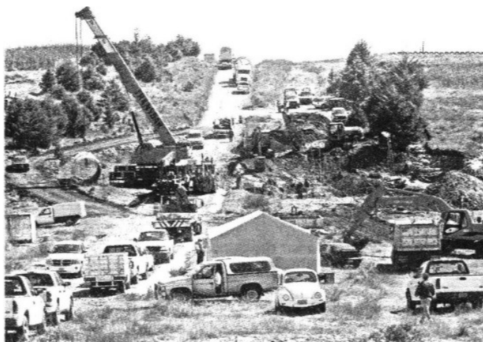
Ayer cuatro excavadoras y dos grúas apoyaron el cambio del ducto fracturado, que sustituyeron por uno de acero de 99 pulgadas de diámetro.
