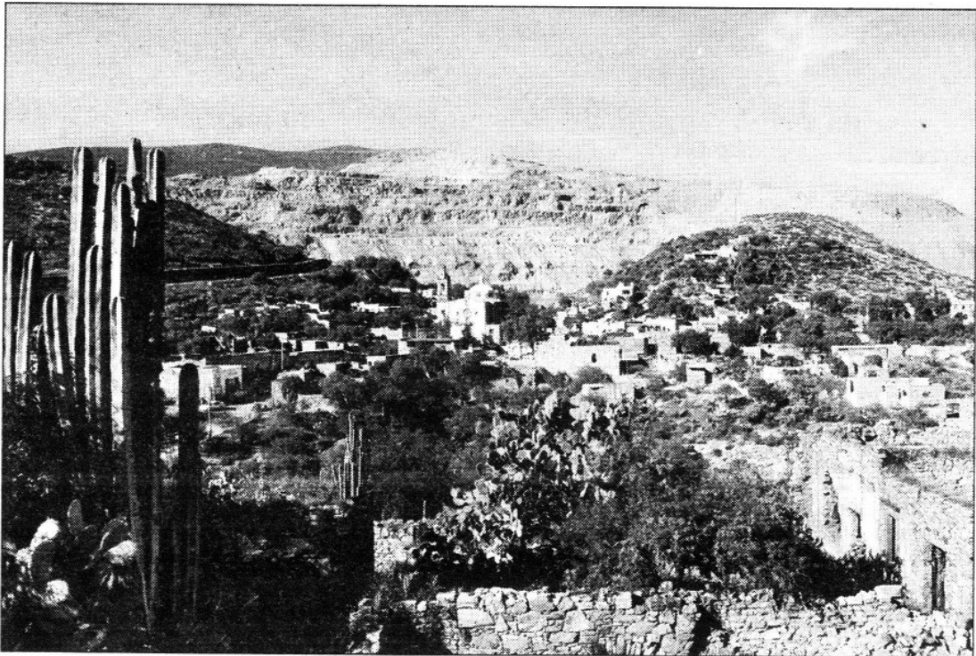
En la imagen de arriba continúan los trabajos de la empresa en la mina. Abajo se observa la destrucción de parte del cerro, considerado un icono en esta localidad ■ Fotos María Meléndrez Parada
