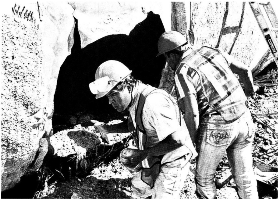
INYECTAN VIDA. Técnicos de la Conagua apuraron la reparación de la tubería afectada en la línea 1, deteriorada por el paso del tiempo. Se espera que el nuevo ducto tengan una vida útil de 30 años.
