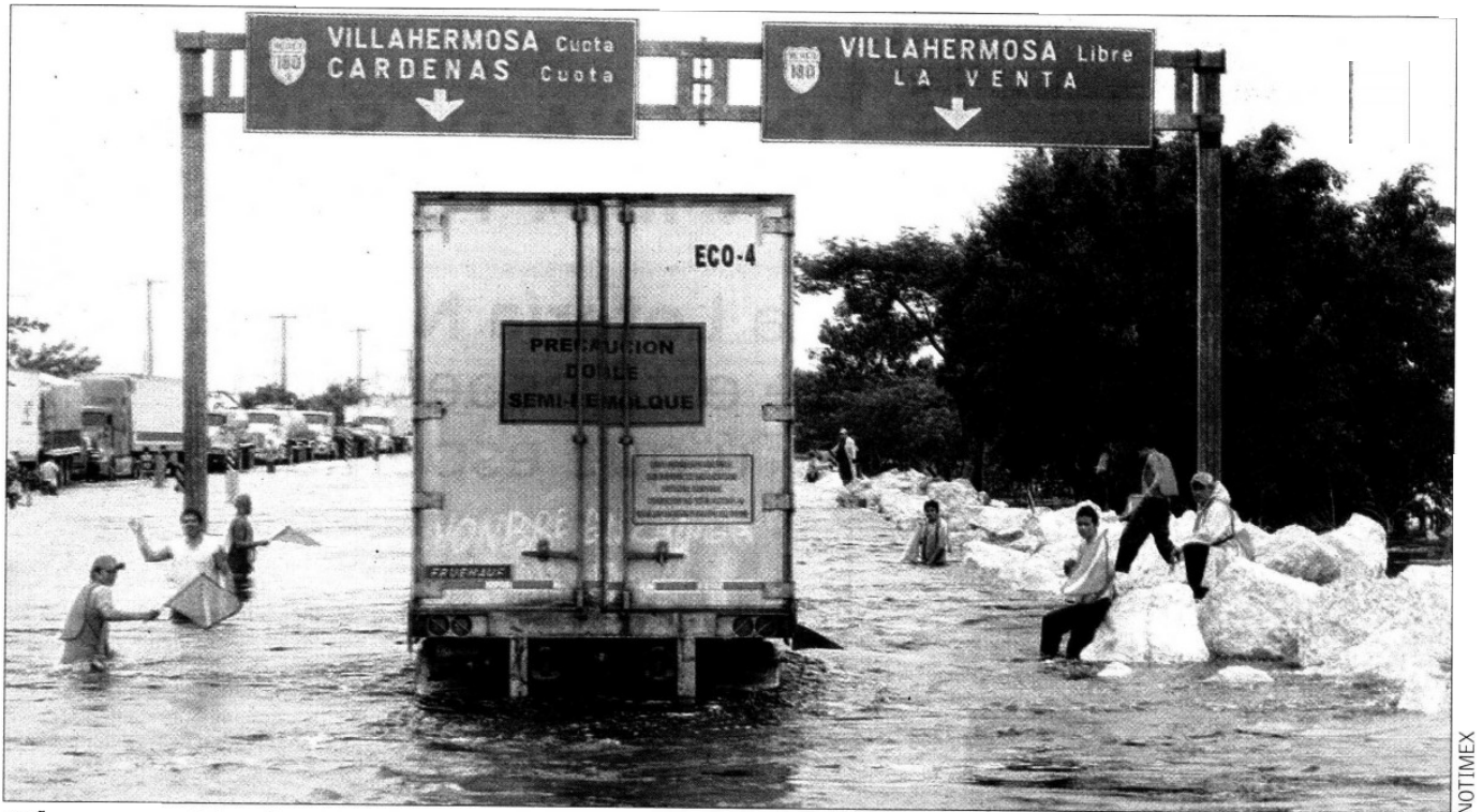
DAÑOS. Las lluvias en Tabasco dejaron inundada la carretera Villahermosa-Coatzacoalcos, por lo que el tránsito en esa vía está suspendido.
