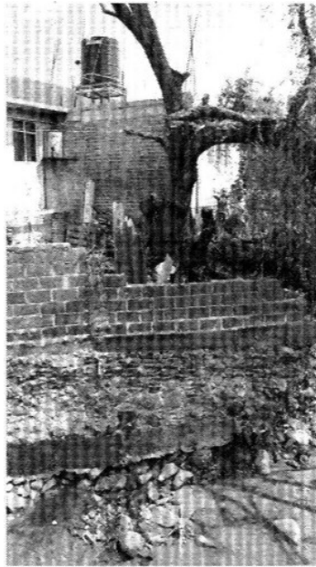
Evalúan en Ecatepec viviendas asentadas a la orilla de la barranca en la Sierra de Guadalupe para dictaminar cuáles están en peligro
