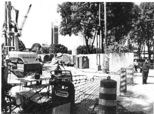
TRABAJOS. En la delegación Benito Juárez se construyen al menos siete de las 20 estaciones de la Línea Dorada
