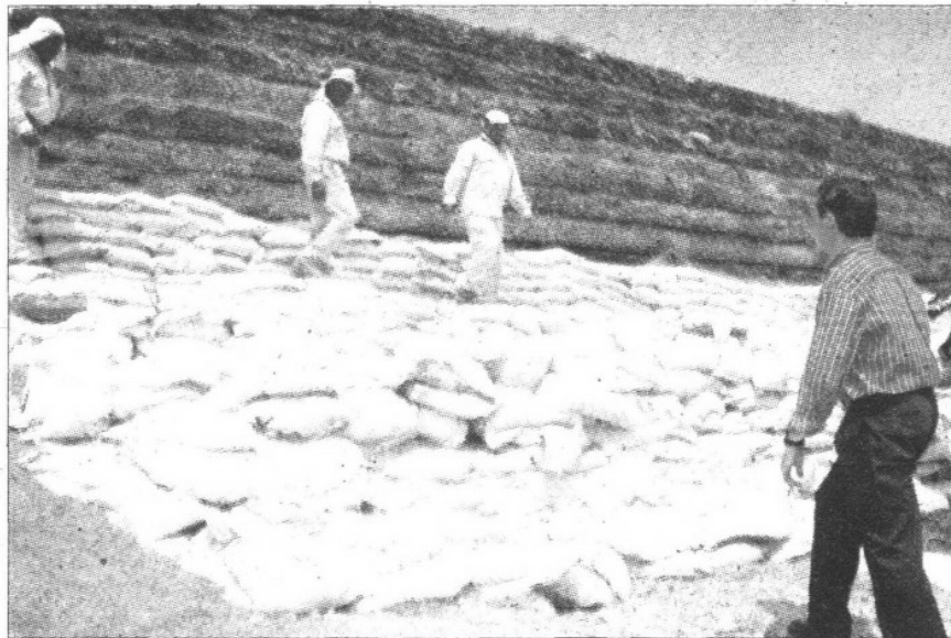
Ixtapaluca, Méx.- El gobernador Enrique Peña Nieto supervisó las obras para la estabilización de los bordos del río La Compañía de este municipio, en el día de su cumpleaños número 43.
