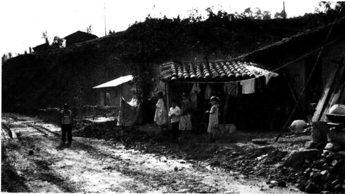
POR INDEMNIZACIÓN. Las familias de Reyna Hernández y Natalia Montealegre se vieron obligadas a desmontar casas o ceder parcelas para la construcción de la carretera que pasa por la comunidad de Mini Numa.
