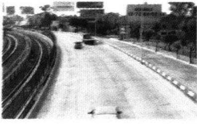
**2 Repavimentación del Circuito Interior (obra concluida).** Esta obra, que se llevó más de un año, implicó la colocación de concreto hidráulico a lo largo de la vialidad, que le permitirá una vida útil de 20 años. En total, fueron por 1 millón 500,000 me-tros cuadrados de reencarpetamiento y 650,000 metros cuadrados de mante-nimiento de áreas verdes.
