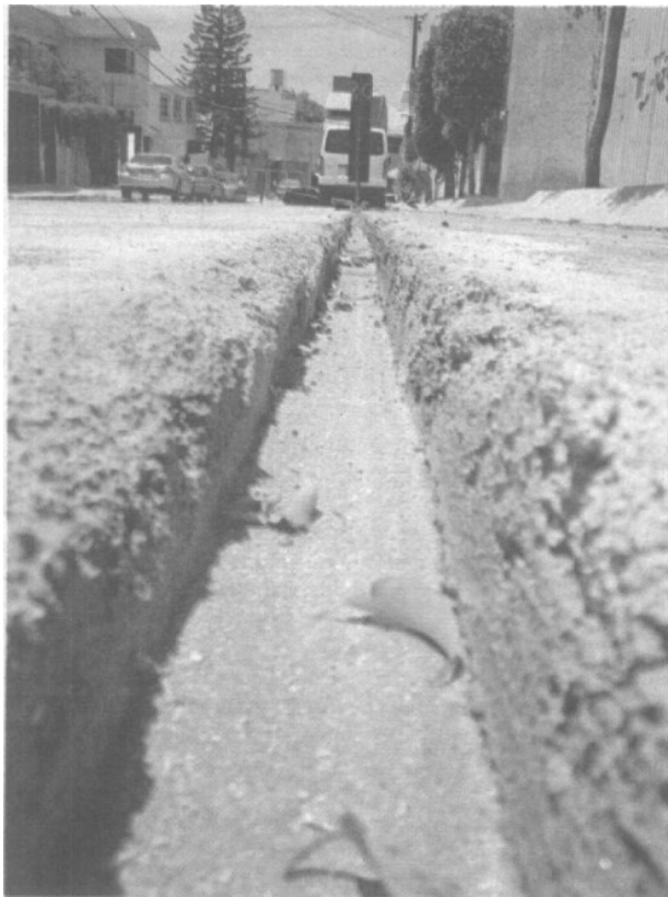
Los trabajadores comenzaron a horadar varias calles donde, según los quejosos, ya se han averiado, en más de tres ocasiones, las conexiones que surten de agua potable
