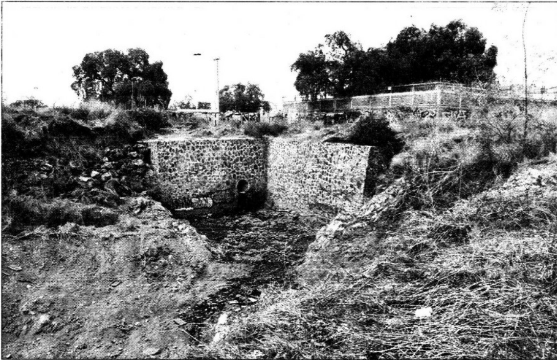
Unos de los pozos de absorción que servirán para disminuir inundaciones en Iztapalapa ■ Foto Guillermo Sologuren
