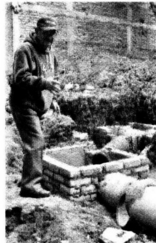
► Anaya mostró la zona donde rehabilitan los registros.
