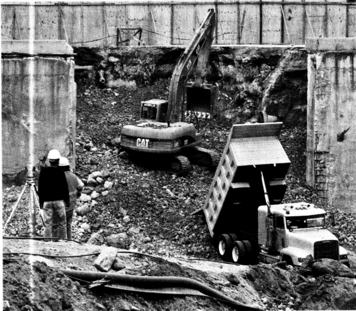
¿ECHEN PAJA? Hasta ayer, 418 camiones ya habían vertido más de 5 mil 800 metros cúbicos de cascajo y grava.
