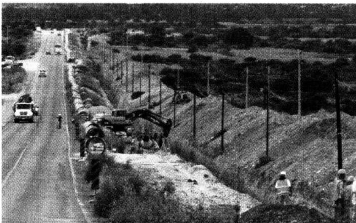
➤ La construcción del Acueducto II contará con 108 kilómetros de longitud y un caudal medio de 1.5 metros cúbicos por segundo.
