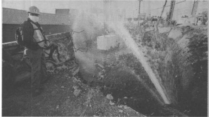
Al inicio el boquete en el tubo de concreto era pequeño, pero la presión del agua lo fue ensanchando hasta llegar a tener un diámetro de unos 15 cm.
