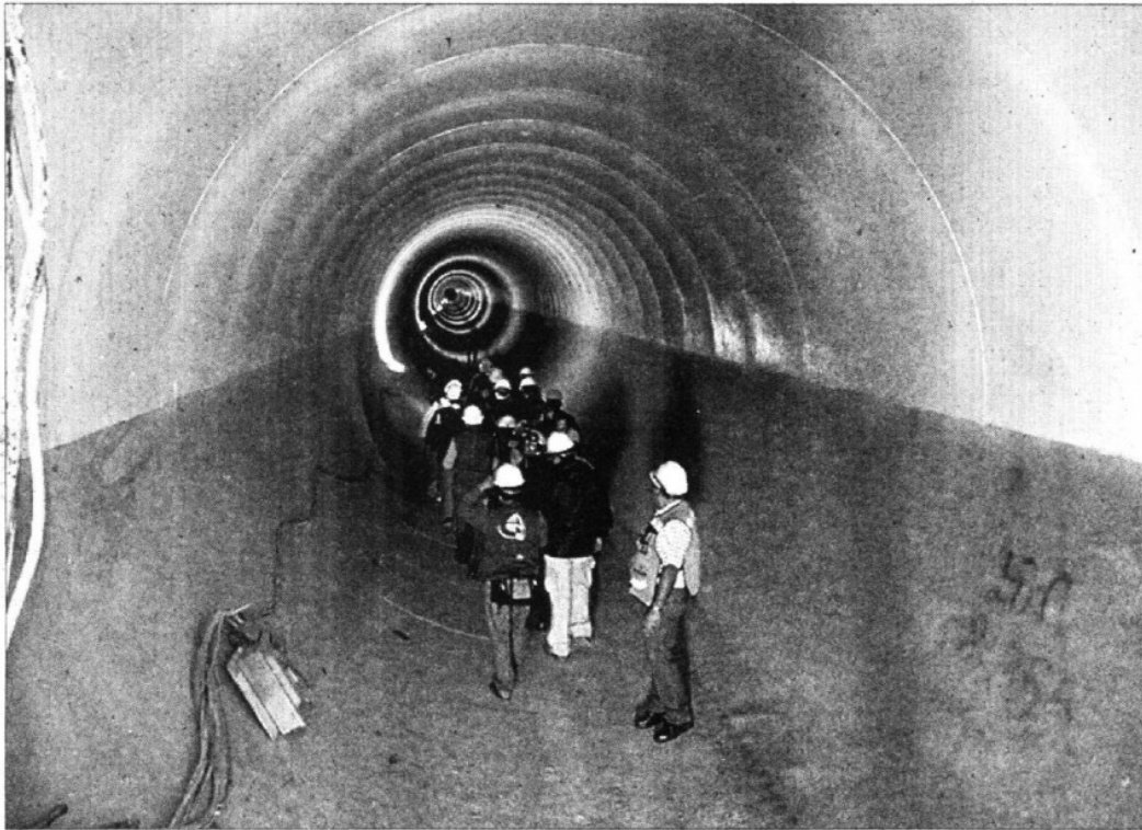
» ASÍ LUCE el drenaje profundo, luego que ser reparado y por donde se desalojará el agua que se acumule durante la próxima temporada de lluvias.
