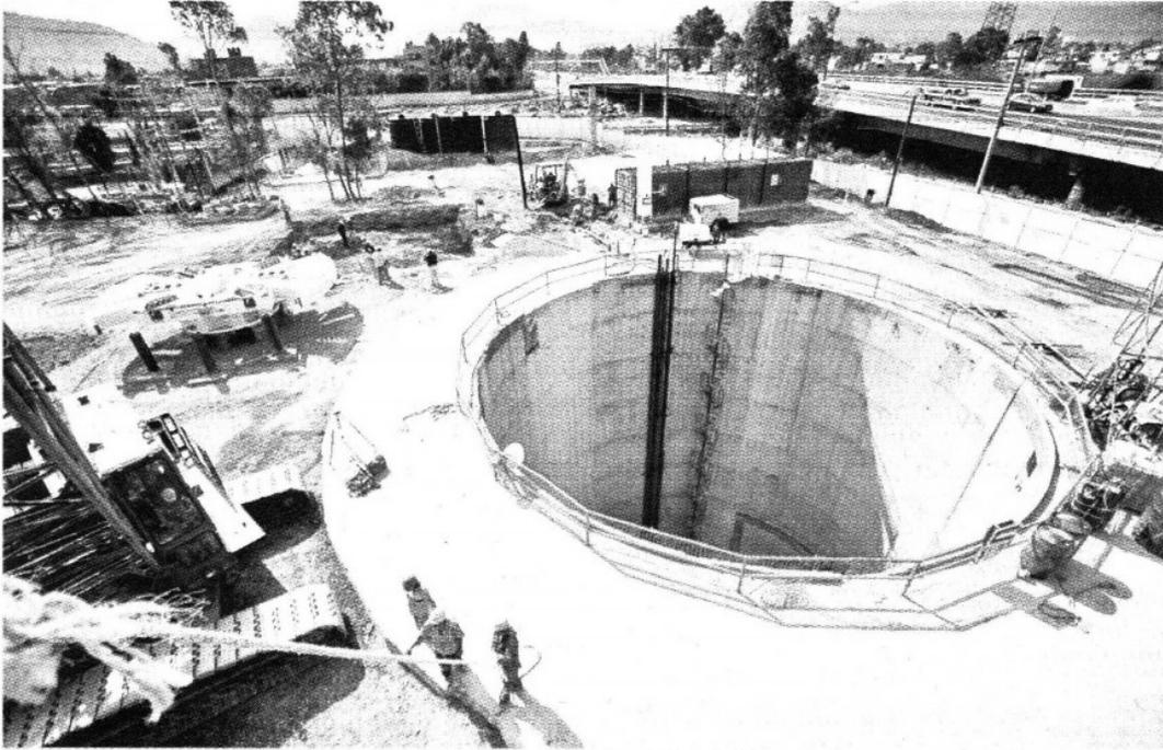
La maquinaria ingresará por la lumbrera, para que a una profundidad de 26 metros, comencen a perforar el túnel que medirá 62 kilómetros.
