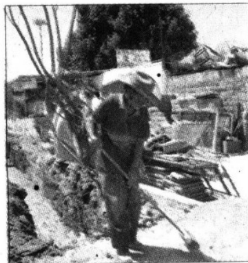
» TRABAJOS DE alcantarillado en León.
