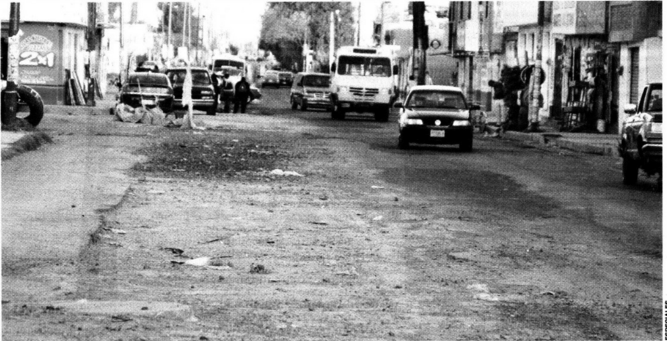
En varias ocasiones se ha colapsado el asfalto; han querido arreglar los desperfectos pero no se logra subsanar los daños
