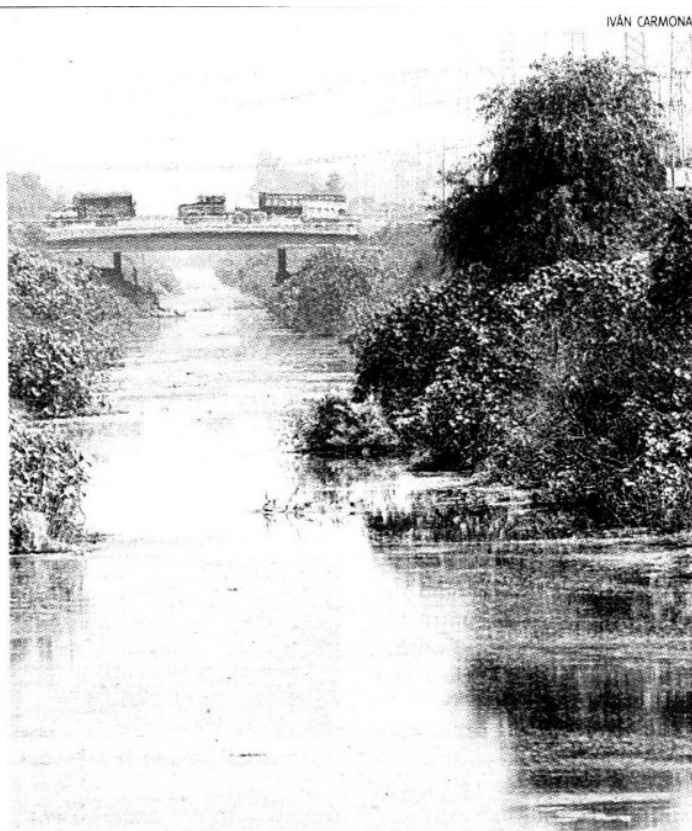
Representa un riesgo de inundaciones
