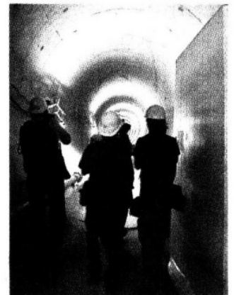
› Con el fideicomiso se financian obras del Drenaje Pofundo.
