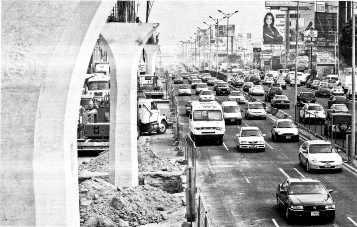
► Las excavaciones para las columnas que sostendrán el paso elevado perforaron un tubo de 30 centímetros de diámetro; con la reparación se van a reubicar 2.5 kilómetros del desagüe.
