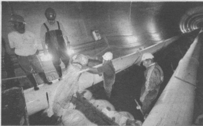
Dos tubos se utilizan para capturar el agua que se está filtrando, y de esta manera tener seco el piso para realizar las reparaciones.
