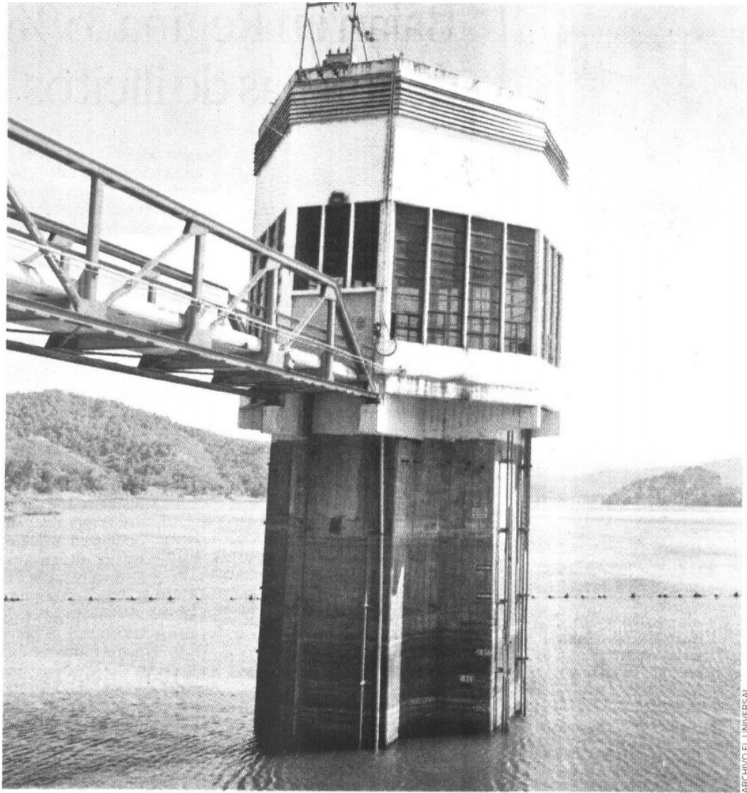
DISMINUCIÓN El racionamiento en el Sistema Cutzamala podría extenderse más allá de mayo por el bajo nivel de las presas. En la imagen, el embalse de Valle de Bravo
