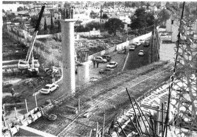
PUENTES El distribuidor vial Muyuguarda se completará con remanentes del Fondo Metropolitano
