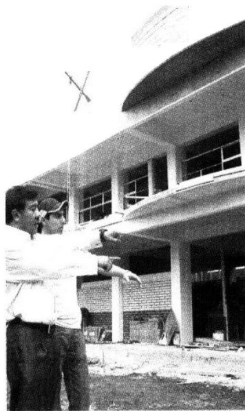
> Erasto Ensástiga, Delegado de Iztacalco (izq.) supervisa las obras.
