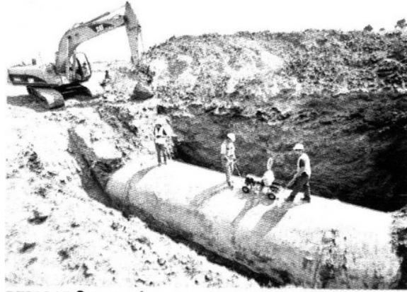
**REPARAR** Comenzó la excavación en dos puntos del km 50 para descubrir el ducto y seccionar los segmentos dañados.
