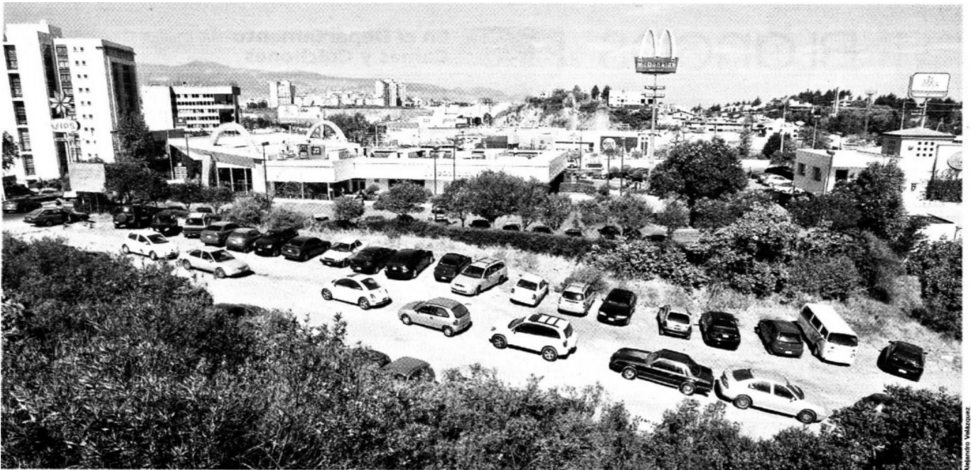
➤ Debido a que la obra vial está detenida, decenas de automovilistas la ocupan como estacionamiento público.
