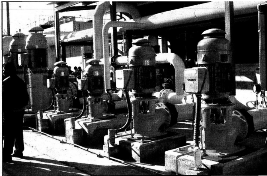
Con la construcción de tres plantas potabilizadoras que costarán 500 millones de pesos, más otra que se inauguró ayer, el GDF pretende enfrentar la escasez histórica y la mala calidad del agua en Iztapalapa
