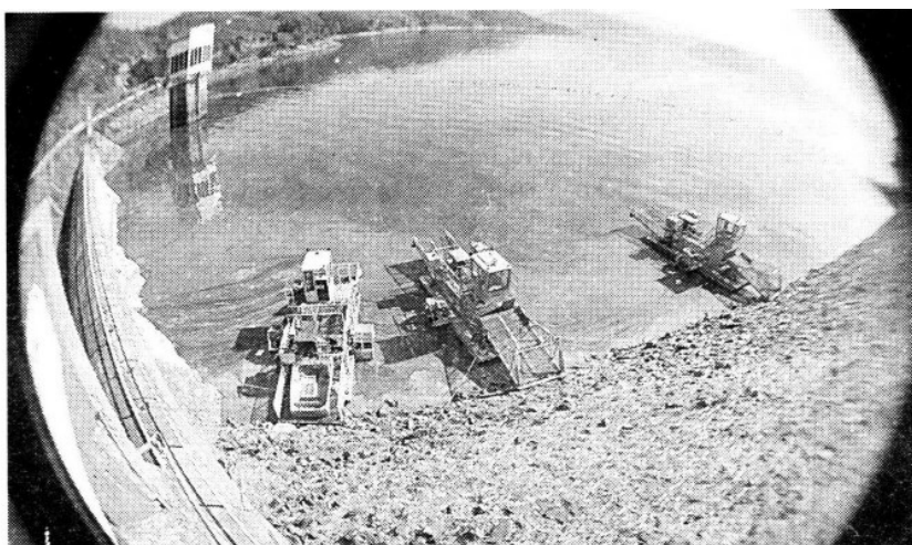
Trabajos de mantenimiento al Cutzamala. (Foto: Cuartoscuro)
