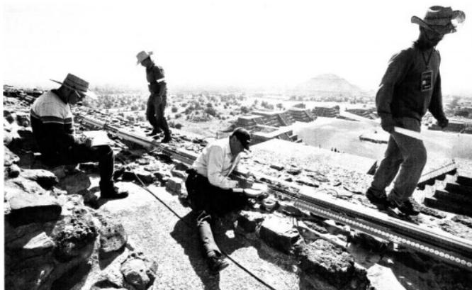
DE PUNTA. Los focos tipo LED colocados en las pirámides del Sol y de la Luna serán controlados por computadora.
