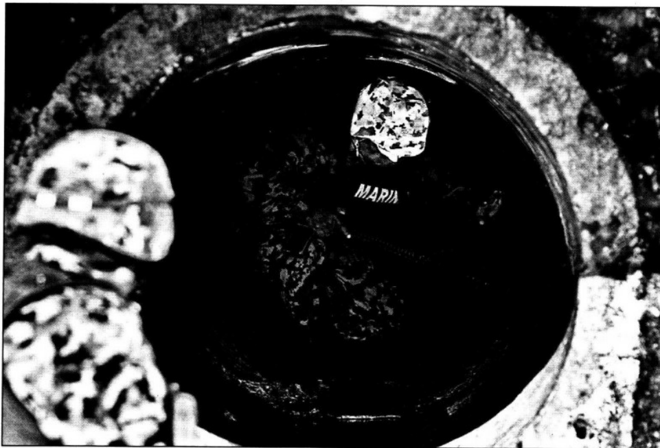
Efectivos de la Armada de México inspeccionan un ducto de drenaje cerca del muro fronterizo con EU en Tijuana, en busca del punto de origen de un túnel que se inicia en esa ciudad y se interna unos tres metros en territorio de San Diego, California ■ Foto Ap
