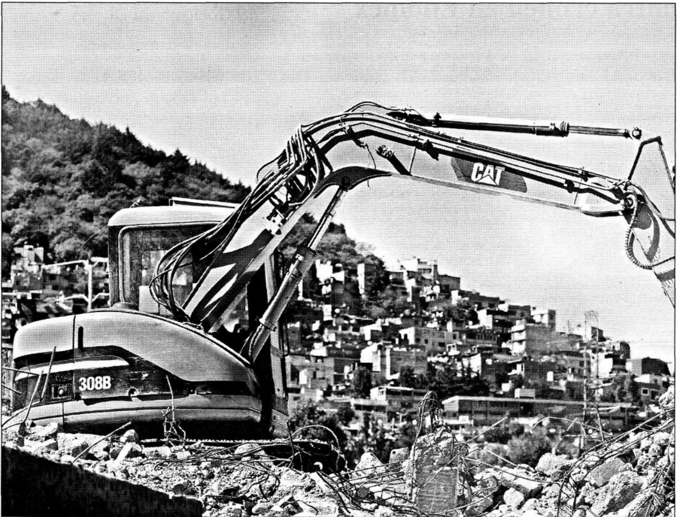
Aspecto de los trabajos de la supervía , donde fueron demolidas las casas de la colonia La Malinche. Imagen de archivo ■ Foto Marco Peláez
