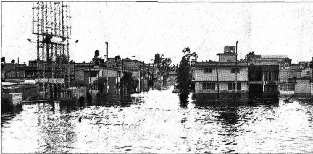
DEBIDO A LAS lluvias atípicas de hace un año se desbordó el Río de los Remedios afectando los municipios de Nezahualcóyotl y Ecatepec, del Estado de México.
