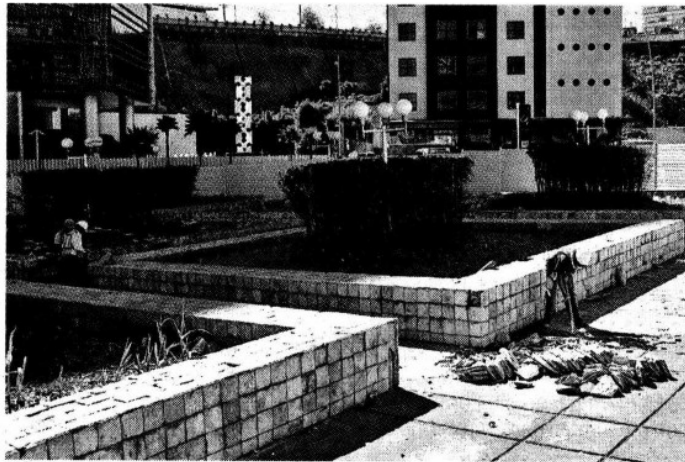
> La construcción de la plaza y el estacionamiento durará 18 meses. En la parte superior, donde ya realizan trabajos, quedará un parque.
