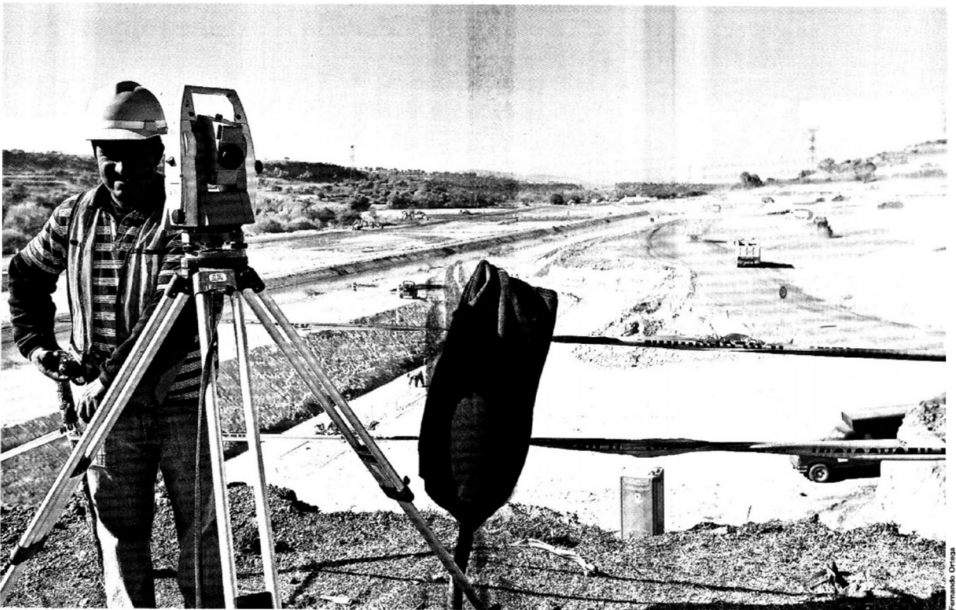
> Actualmente laboran en la región de Atotonilco, Hidalgo, 400 trabajadores, la Conagua prevé que para mediados de este año la cifra de empleo se eleva a su máximo de 4 mil obreros. Se prevé que la PTAR Atotonilco quede terminada en agosto de 2013.
